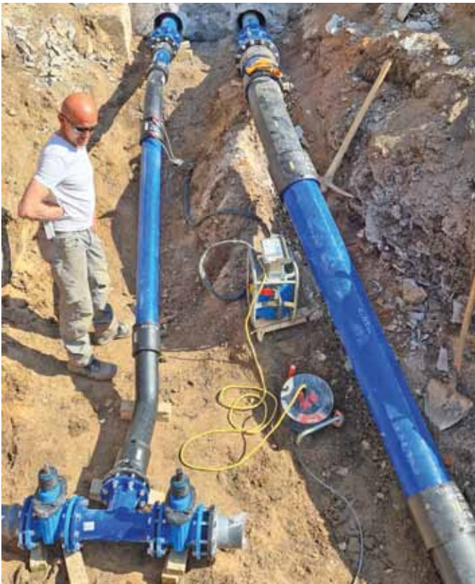
Der Wasserzweckverband Kindinger Gruppe investierte im vergangenen Jahr rund 400.000 Euro in die Infrastruktur der Wasserversorgung. Die beiden größten Baumaßnahmen waren die Sanierung des Ortsnetzes in Emsing sowie die Erneuerung der Wasserleitung Kratzmühle – Pfraundorf (Bild). Weitere Investitionen von rund 1,7 Millionen Euro sind für das Jahr 2023 geplant, wie Geschäftsführer Andreas Schuster in der Verbandssitzung bekannt gab.
