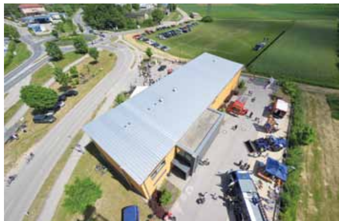
Der Bayerische Landesfeuerwehrverband (LFV) beabsichtigt, ein Jugendfeuerwehrausbildungszentrum sowie ein Logistikzentrum der Bayerischen Feuerwehren (BayJFALZ) in Kinding, Landkreis Eichstätt, zu errichten. Für das geplante Gebäude mit Tagungsräumen hat der Markt Kinding dem LFV in Aussicht gestellt, das gemeindeeigene, erschlossene Grundstück – parallel zur schwarz eingezeichneten Linie – neben dem Feuerwehrhaus am Kindinger Kreisel anzubieten. Bild: Feuerwehr Markt Kinding, (Archiv)
