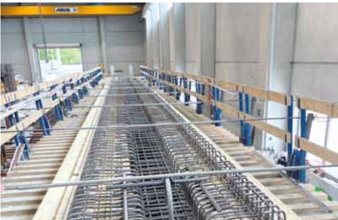
Die acht Fahrbahnelemente aus Stahl und Beton werden in Straubing gefertigt.
