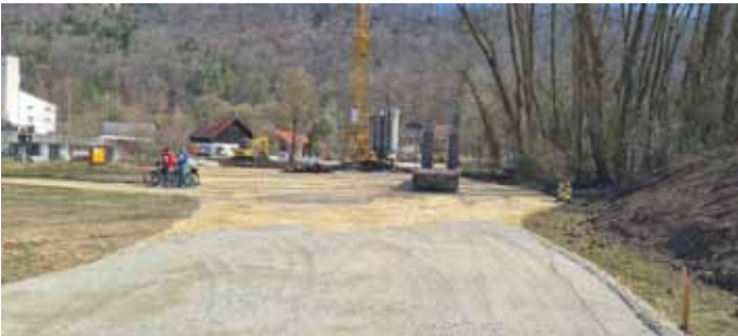
Unterbau für die neue Zufahrt zum Ortsteil Kratzmühle.
