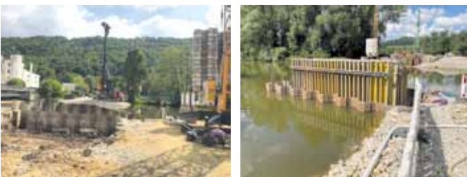
Spundwand und Schalung für den Mittelpfeiler
