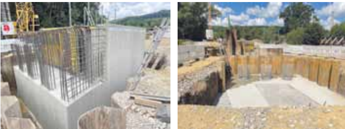
Die Widerlager auf beiden Seiten werden errichtet. Bohrlöcher für das Widerlager.
