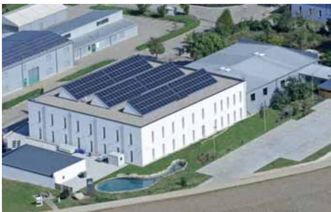
Ein perfekt gelungenes Projekt: das neue Mechatronikerzentrum von ETS DIDACTIC, innovativ in seiner Bauweise als Ziegelmassivbau und nachhaltiger, CO 2 -freier Klimatisierung. (Foto: ETS DIDACTIC GMBH – Leonhard Gommel)
