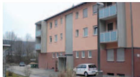
Das „Überlandwerk“ wurde weitgehend in Eigenleistung der Bauhelfer saniert. Dort werden derzeit 18 unbegleitete minderjährige Asylbewerber betreut.
