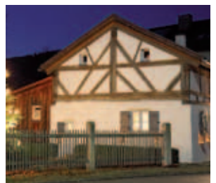
Nach einer Renovierung strahlt das Hirtenhaus Unteremmendorf in neuem Licht
