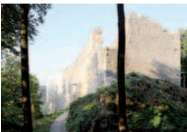
Fast neu strahlt die Rumburg über Enkering nach Sicherheitsmaßnahmen
